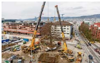
Zwei Pneu Kräne haben den rund 20 Meter hohen Baum angehoben.
